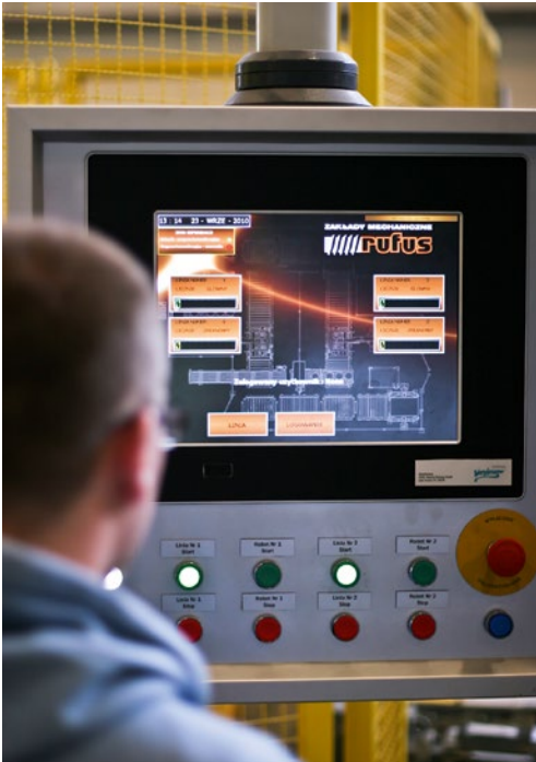
Desenul 2: Panoul de comandă pentru operarea liniei.
